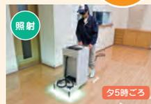
専用の機械で光を当て、瞬時に強固な樹脂膜を形成します。
